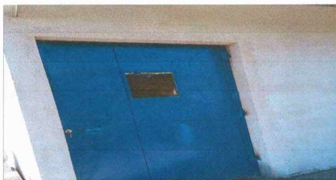
Foto 3: COLOCACION DE PUERTA DE ESCUELA FINALIZADO
