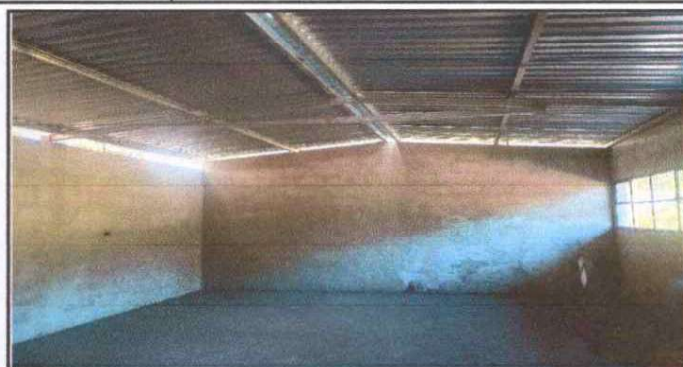
Foto 2: REPELLO FINALIZADO AL 100% EN INTERIOR DE ESCUELA.
