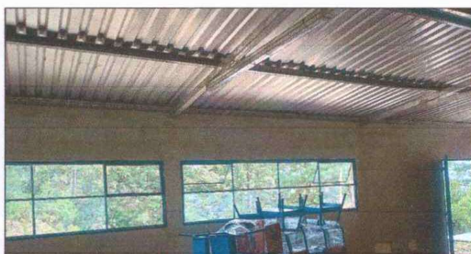
Foto 4: SUSTITUCION DE VENTANAS AL 100% FINALIZADOS
