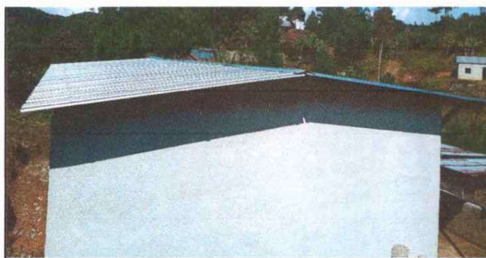
SUSTITUCION DE LAMINAS FINALIZADAS
