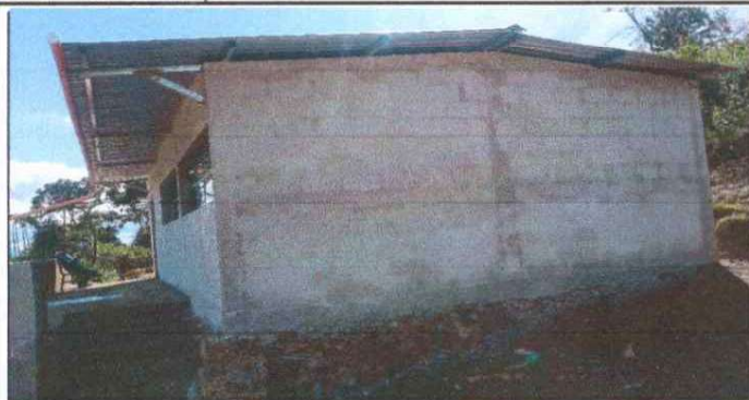
Foto1: REPELLO AL 100% FINALIZADO EN LA PARTE EXTERIOR
